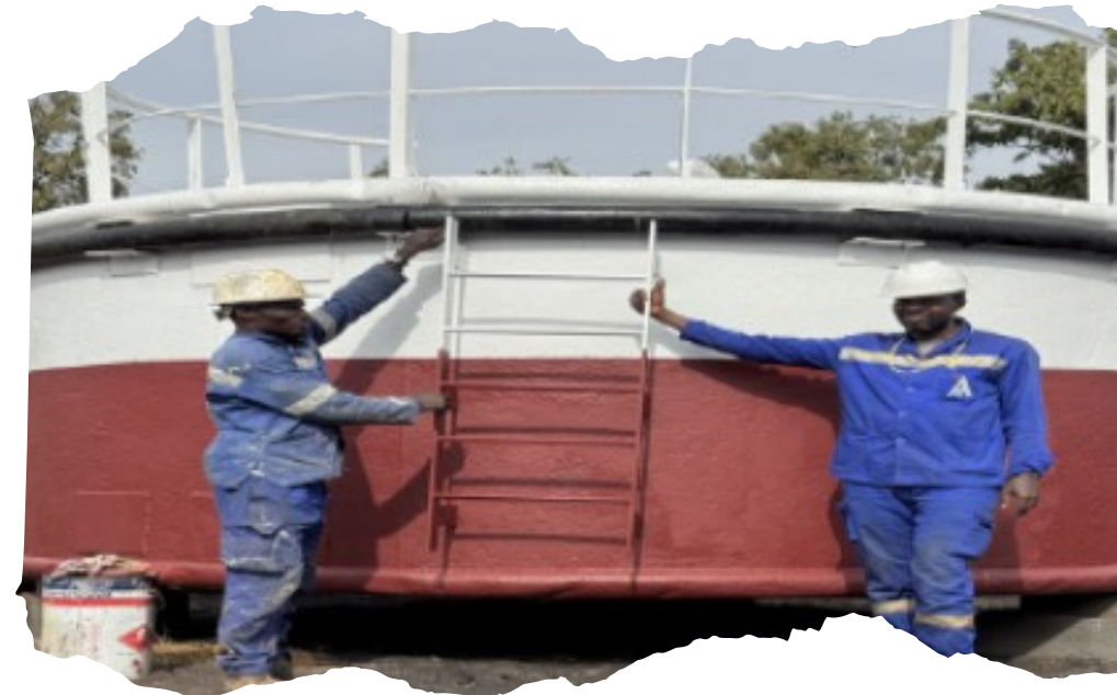
Travaux d' entretien des coffres d'amarrage Client : Société Africaine de Raffinage (SAR)
