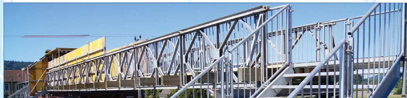
Ouvrage d'art et de franchissement (pont et passerelles)
