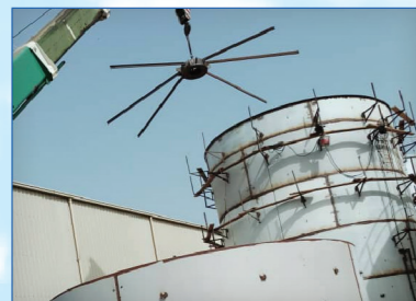
Bacs en cours de montage
