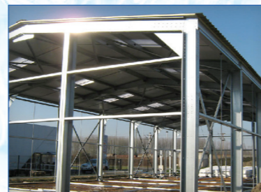
Charpentes métalliques et divers ouvrages
